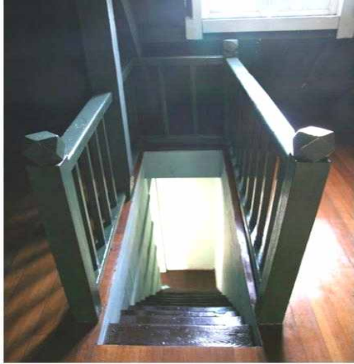
1층 상부 계단
