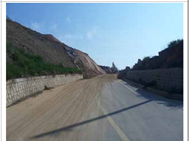
민머루 진입로 도로확포장공사
