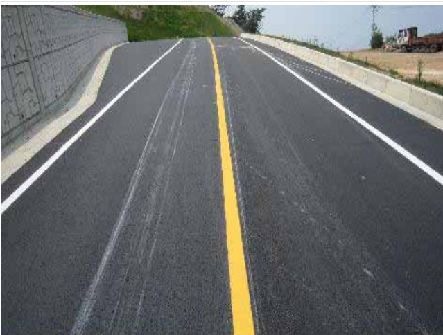
민머루 진입로 도로확포장공사
