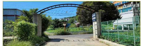
■ 지장물 - 문주 및 능형망 펌프
